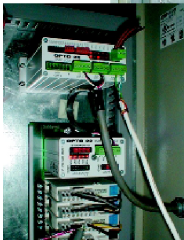
Controlador SNAP-LCSX-PLUS, procesador B3000, y módulos SNAP en un sitio remoto
